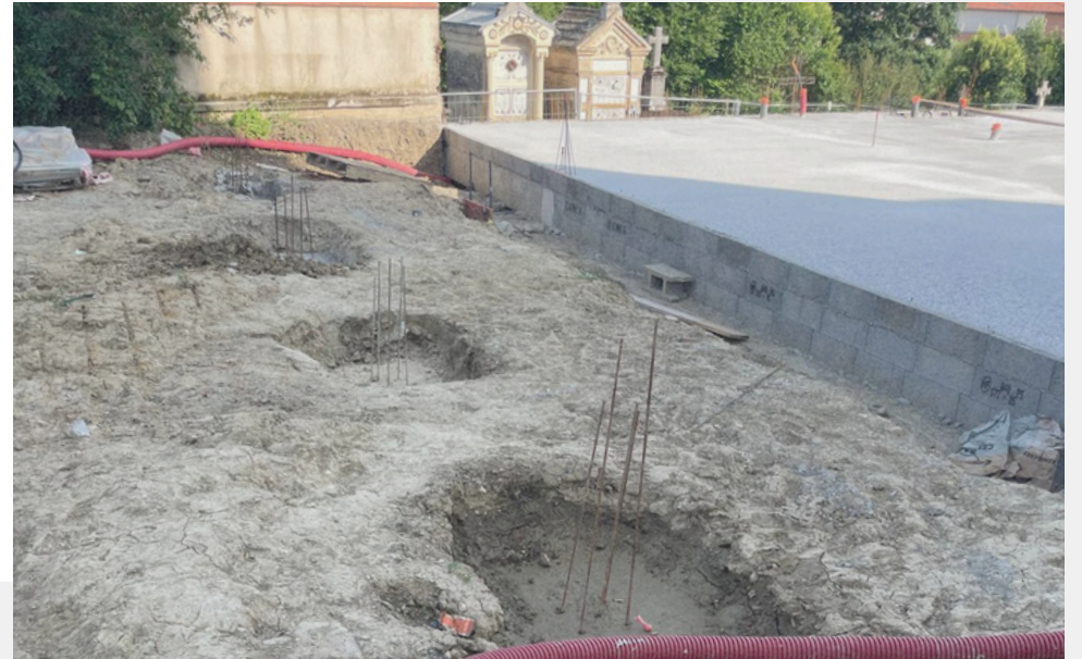
Ferrailage des poteaux
