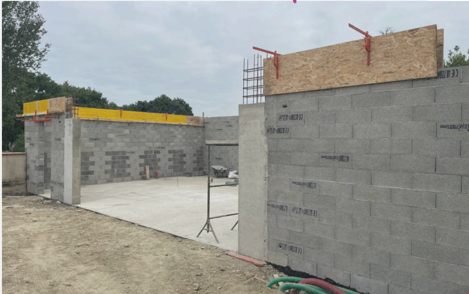
Murs prêts pour le plancher du 1er étage
