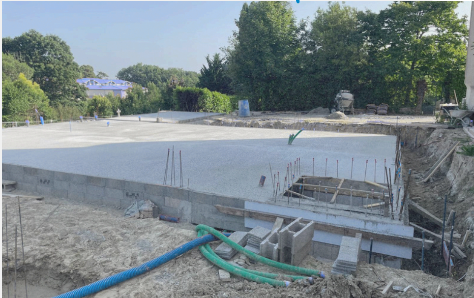
Béton Plancher
