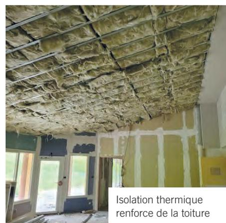
Isolation thermique renforce de la toiture
